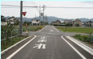
基幹事業: 道路(村道2-13号線改良)
