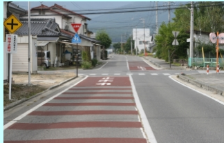
基幹事業: 道路(村道1-10号線交差点改良)
