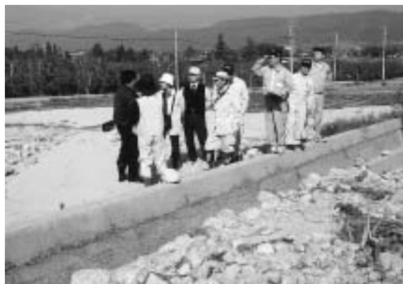
川西地区の土砂流出現場を視察中
