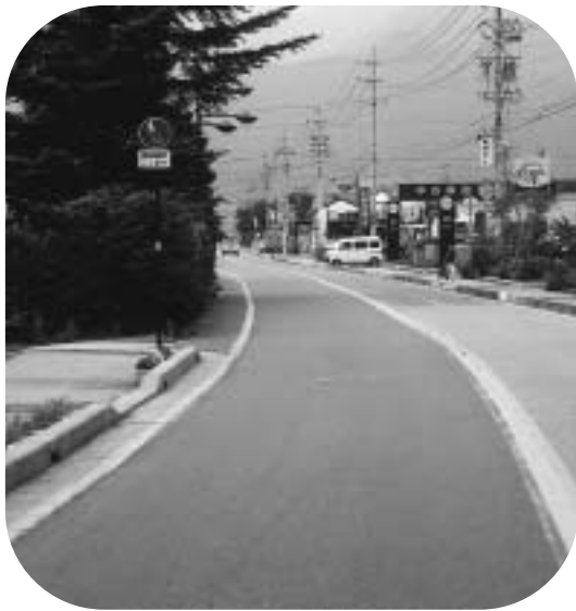
安心の通学路など期待できる県道歩道予定地 (高瀬大橋から西方面)
