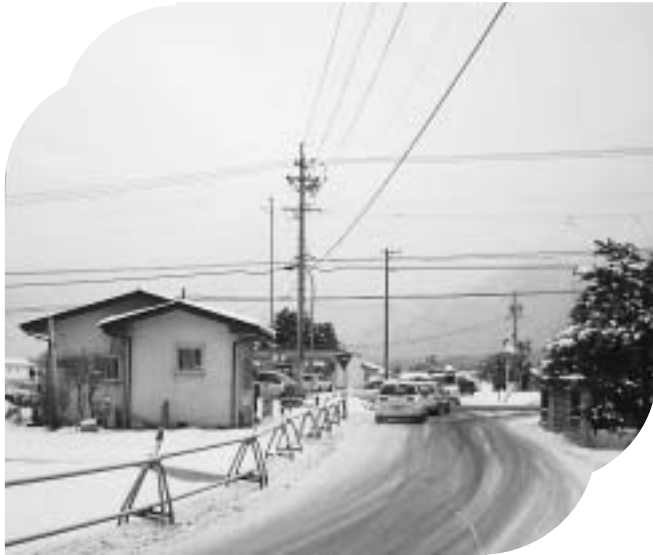
信号機設置のため村道拡幅工事中の北細野駅西
