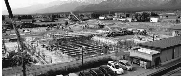
順調に進む、多目的交流センター建設工事
